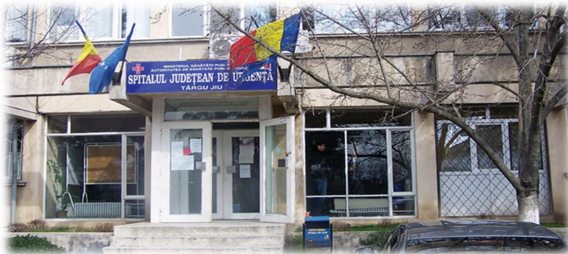
Fig. 2.102. Clădirea Spitalului județean de Urgență din Tg-Jiu va fi echipată cu panouri termosolare în anul 2021
