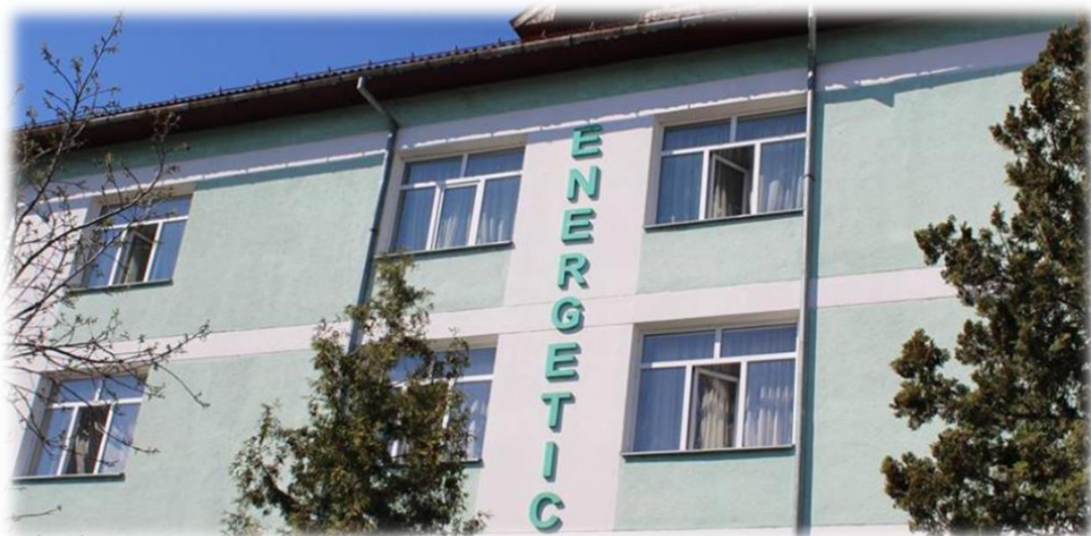
Imagine cu Liceul energetic din TgJiu unde au fost amplasate panouri fotovoltaice
