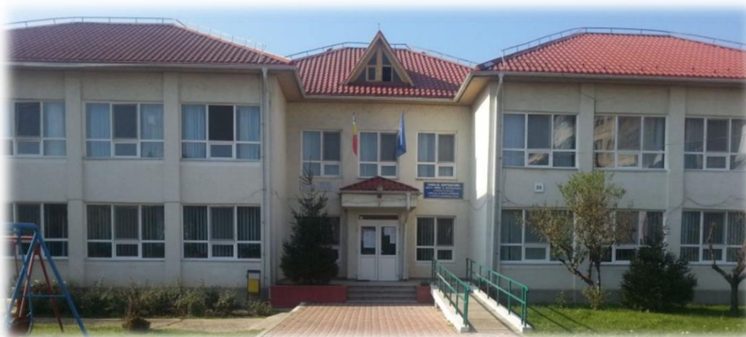
Fig. 2.101. Complexul de servicii alternative la protecția copilului a fost dotat cu panouri termosolare
