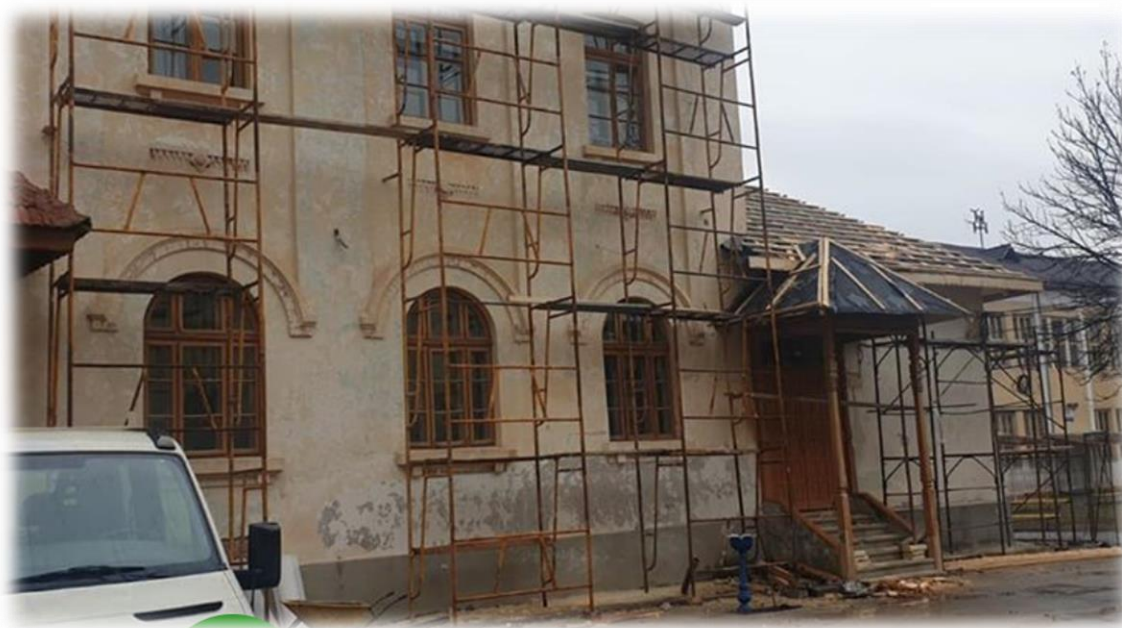
Fig. 2.98. Lucrări de reabilitare termică la Colegiul Național Spiru Haret
