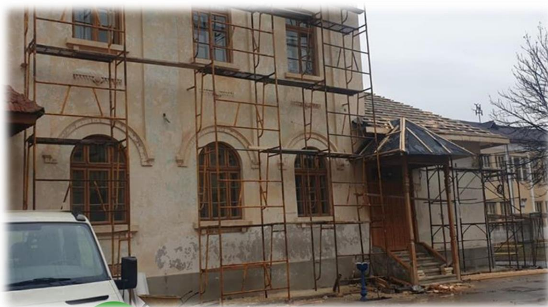
Lucrări de reabilitare termică la Colegiul Național Spiru Haret
