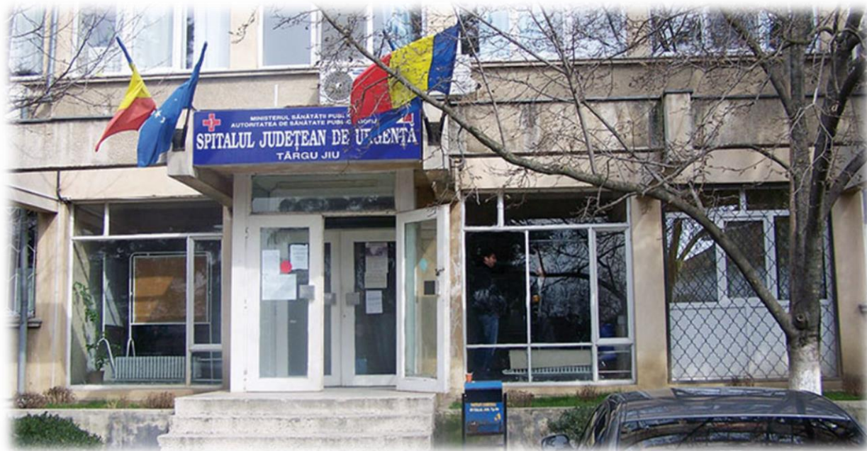
Clădirea Spitalului județean de Urgență din Tg-Jiu va fi echipată cu panouri termosolare în anul 2021
